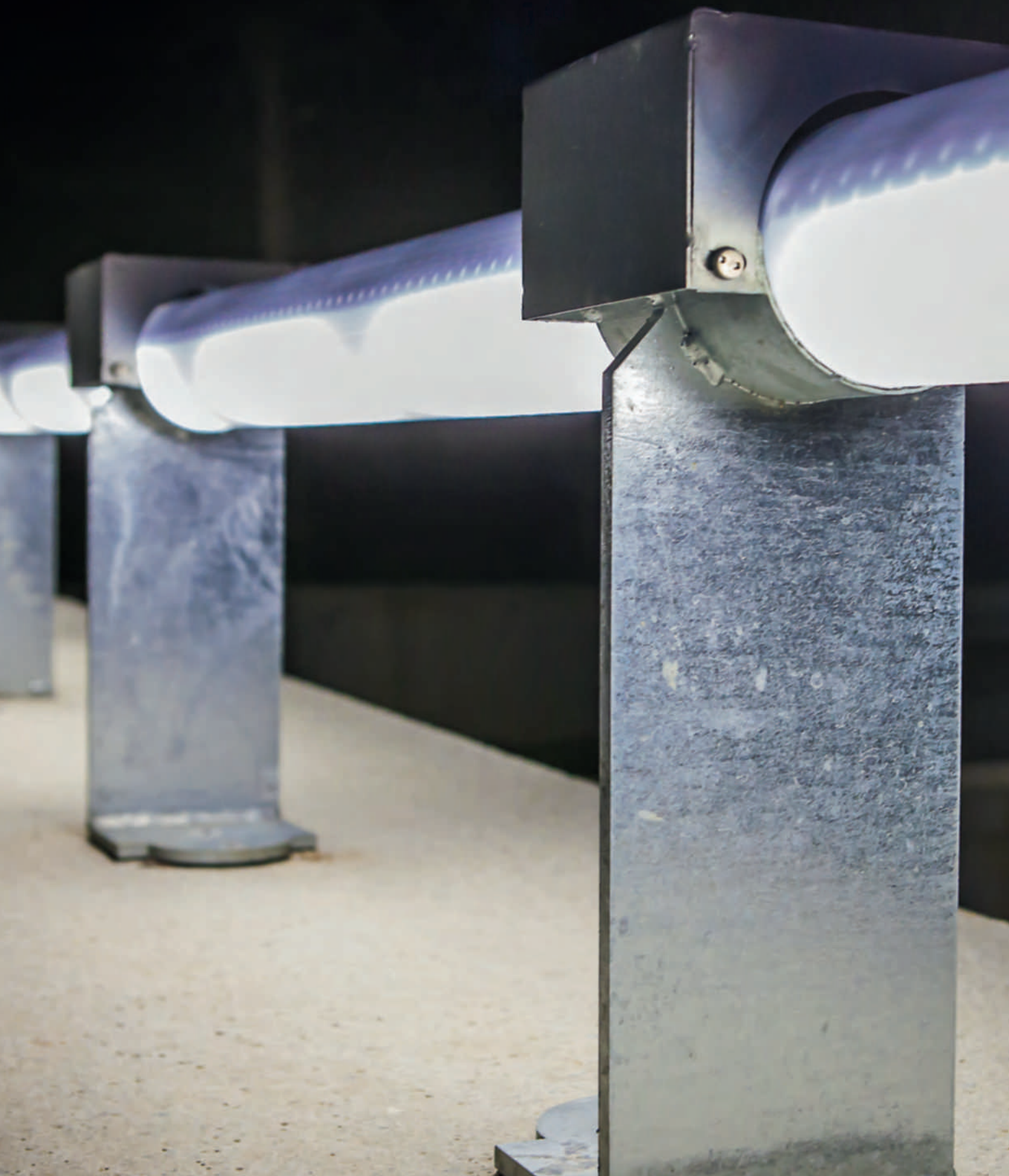
Luminaria personalizada tubular opal con módulos LED IP68 Meandro de Aranzadi, Pamplona, España Custom tubular opal luminaire with LED modules IP68 Aranzadi Meander, Pamplona, Spain Luminaire creation sur mesure de tubulaire opale avec des modules LED IP68 Méandre d'Aranzadi, Pampelune, Espagne
